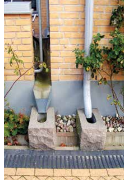
Resim 2. İsveç'in Malmö kentinde "Geleceğin Kenti" sloganıyla tasarlanmış olan Bo01 kentinde yerleşme örüntüsü ve yağmur suyunun toplandığı mavi-yeşil altyapı elemanları (Urban Blue Grids, 2021).
